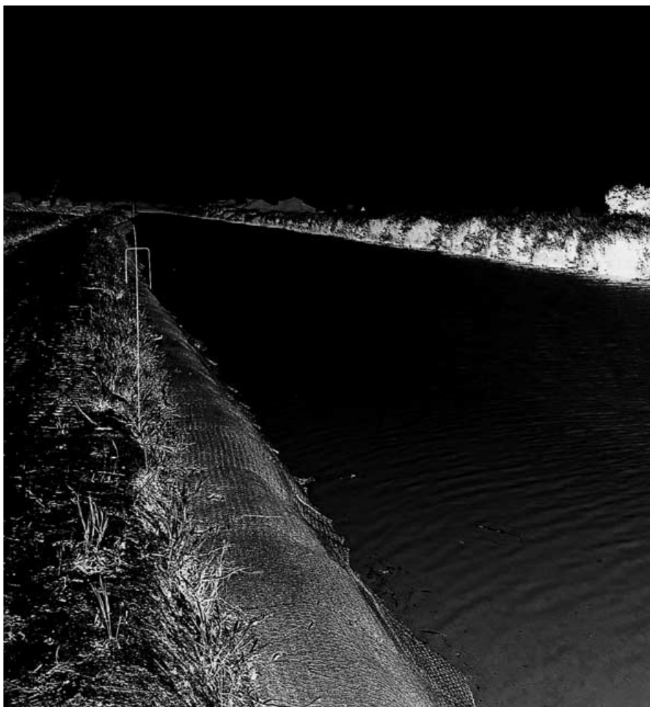
Fig. 8 - Tratto arginato protetto con rete.
