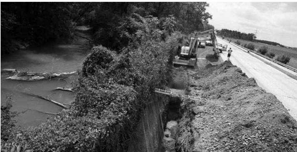
Fig. 13 Riparazione dell'argine lungo l'autostrada Lyss-Bienne in Svizzera.
